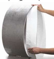
2-Colocar en tubería
